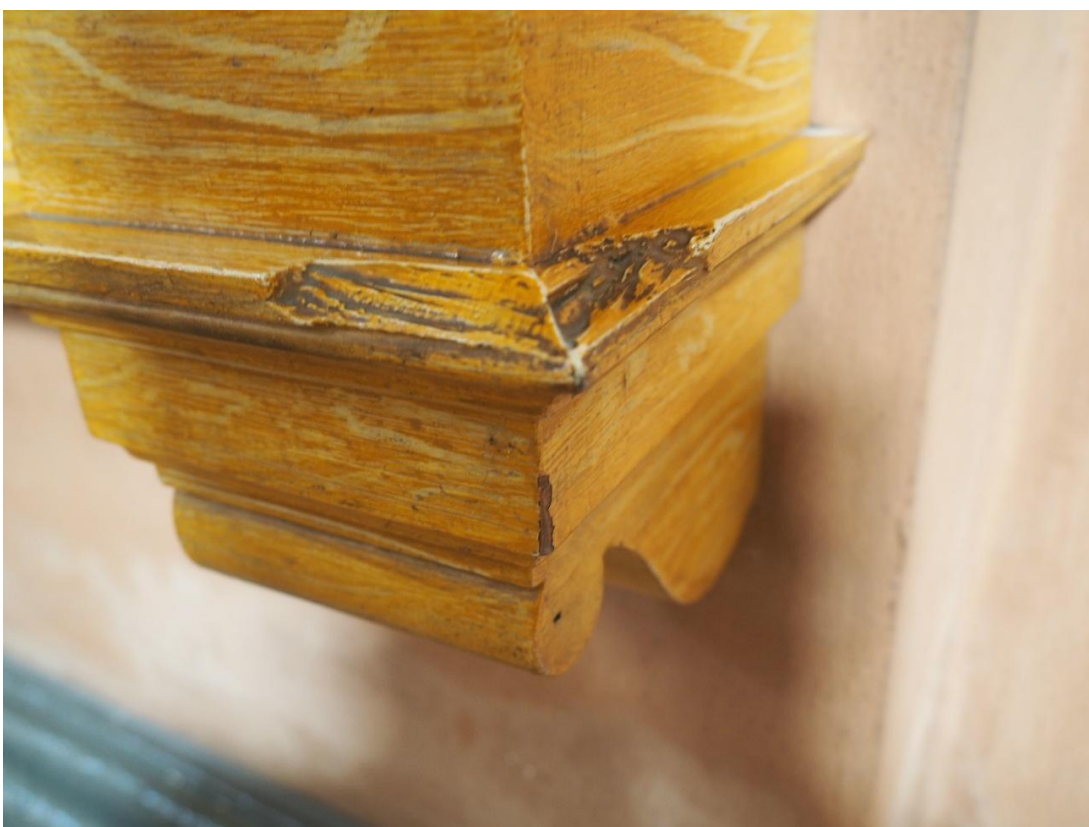
Il. 88 i 89. Stacje Drogi Krzyżowej w kościele p.w. św. Jana Chrzciciela w Legnicy. W miejscu ubytków obecnej warstwy malarskiej na ramie widoczna jest starsza, oryginalna/?/ warstwa fladrunku w kolorze ciemnobrązowym. Przemalowanie w kolorze ugrowym położono także w ubytkach drewna.
