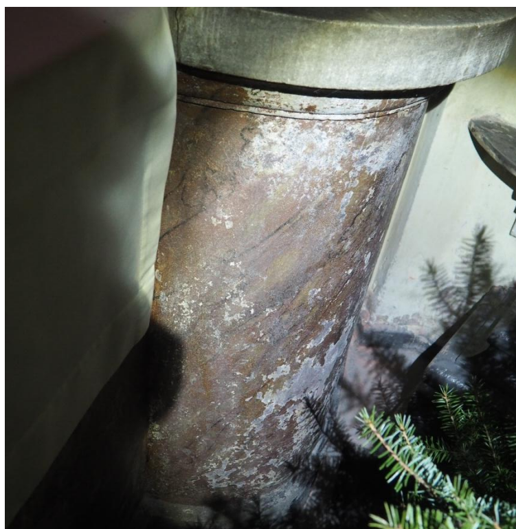
Il. 30. Ołtarz boczny p.w. NMP w kościele p.w. św. Jana Chrzciciela w Legnicy. Widoczne ubytki polichromii oraz zasolenie/?/ na murowanych cokołach ołtarza. Fot. K. Samborski, 2022r.
